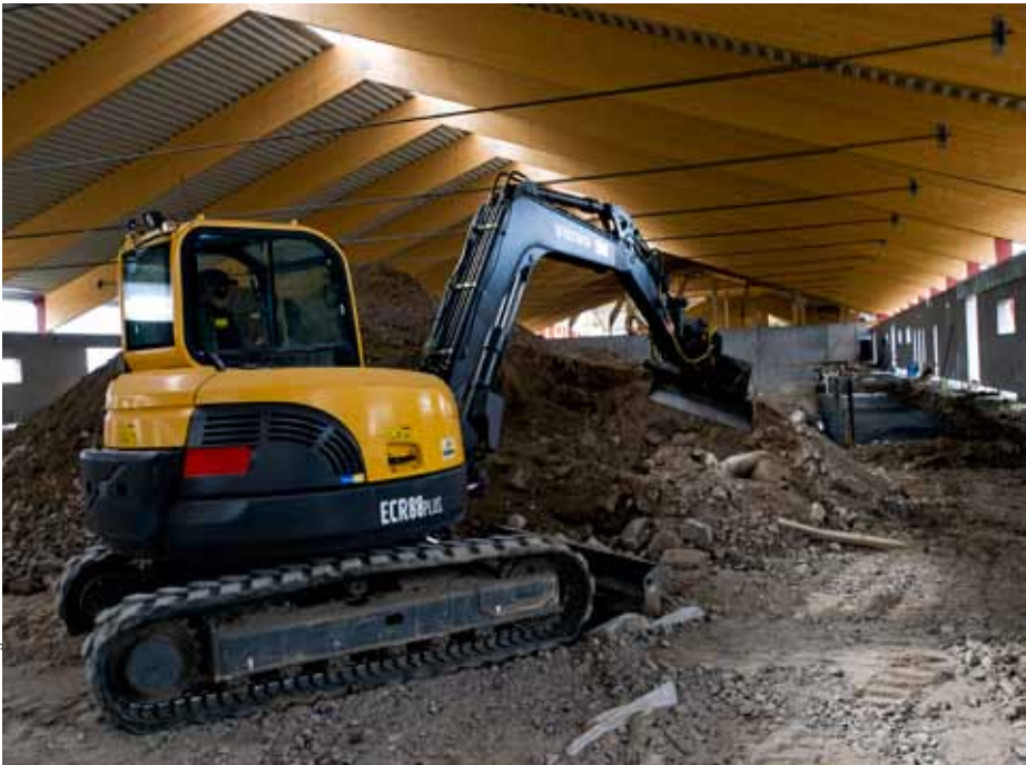
Allt sedan det första spadtaget i augusti 2009 har det grävts på Lövsta.
